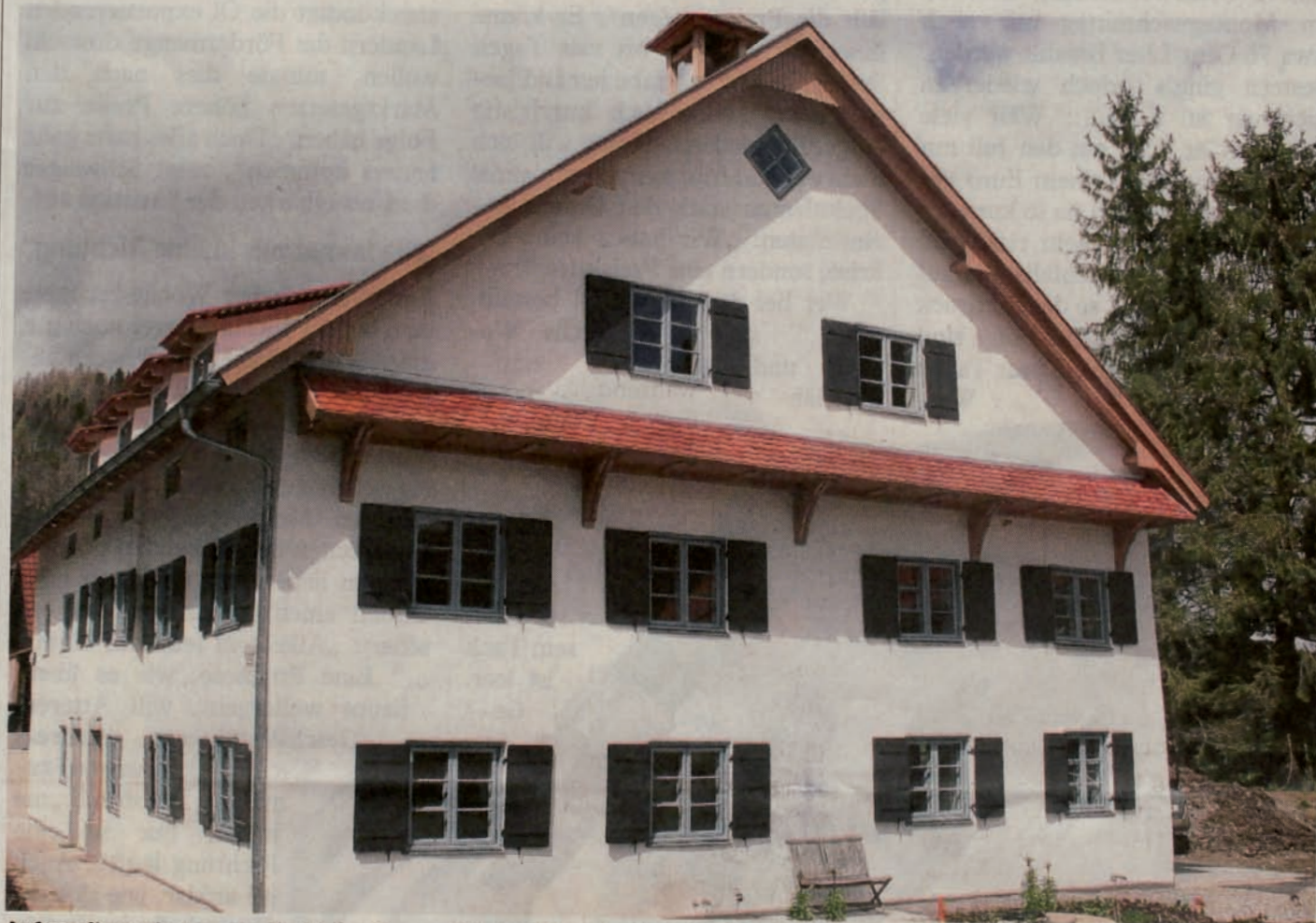
Aufwendig saniert wurde die Liebenthannmühle bei Obergünzburg im Günztal. Auch dieses private Bauvorhaben wird vom Landkreis Ostallgäu mit einem Zuschuss unterstützt.
